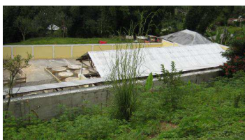
Unité 100 m 3 alimentant 1 groupe de 15 kWh
