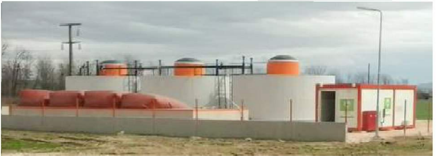
Macédoine - Lisier bovins / cogénération 25 kW
