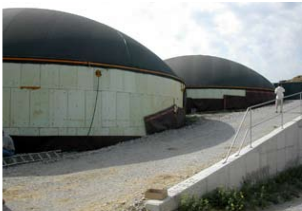
Photos 1 et 2 : unité de traitement des déjections animales : digestion anaérobie (à gauche) et traitement biologique de l'azote (à droite).
